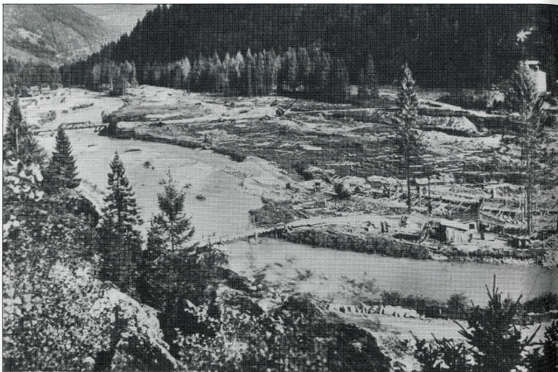
Bocca di Genoa durante i lavori del bacino
